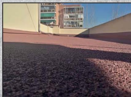
Imperméabilisation avec particules de caoutchouc
